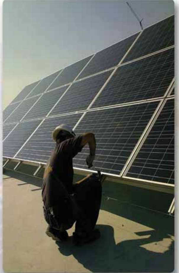
Turkcell Çeşme Baz İstasyonu Kurulumu
