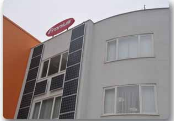
Fronius Binası Fotovoltaik Cephe Uygulaması
