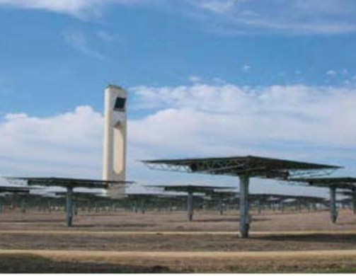
Aynalar, Solúcar kulesinin tepesinde bulunan alıcıda 600 güneşin gücünü toplamaktadırlar
